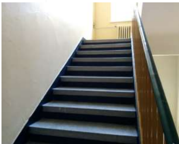
Zdjęcie nr. 6 Przykładowa poręcz przyschodowa – wysokość 1,14 cm
